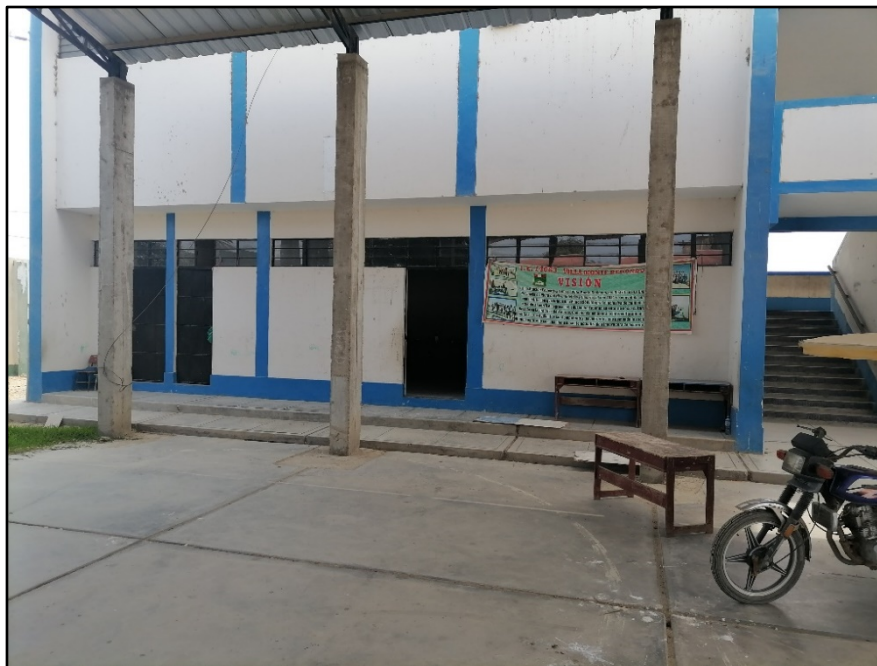
Foto N° 7: PERSPECTIVA DEL BLOQUE 08 EN REGULAR ESTADO EN SU ESTRUCTURA , SALVO EL DETERIORO DE PINTURA Y LOS VIDRIOS SIMPLES QUE NECESITAN SU CAMBIO POR NO SER LOS RECOMENDADOS DE ACUERDO CON EL MARCO NORMATIVO,
