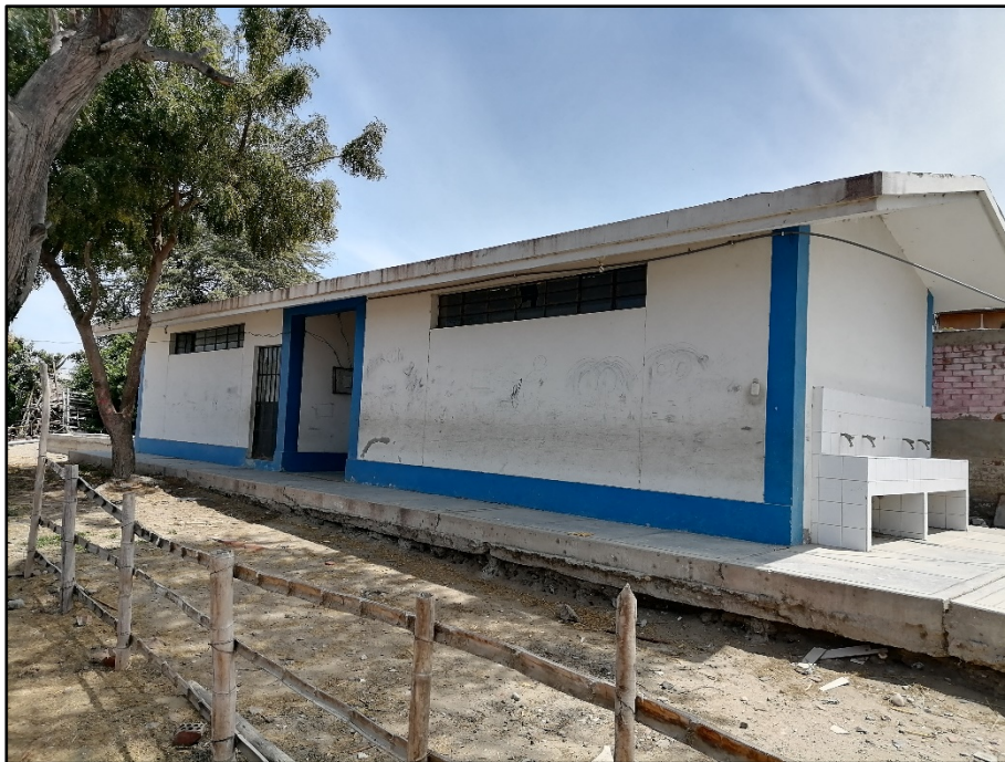
Foto N° 5: EN ESTA TOMA APRECIAMOS LA PERSPECTIVA DEL BLOQUE 06 EN ESTADO REGULAR EN SU ESTRUCTURA , SALVO LA AUSENCIA DE CANALETAS PARAY ELA RAJADURA DE VERDAS.
